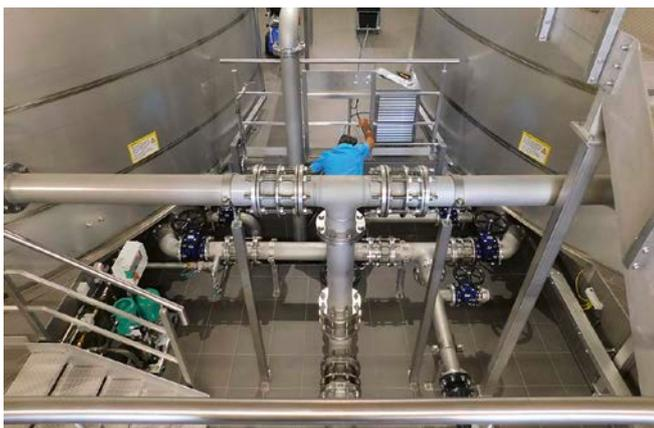
Ein Blick ins Innere des Hochbehälters Obernberg: Das Rohrleitungssystem sorgt dafür, dass das Wasser der beiden Behälter (links und rechts) mit je 300 m<sup>3</sup> Fassungsvermögen die Wasserversorgung von Schauling und Teile der Gemeinden Auerbach und Hengersberg sicherstellen kann.
