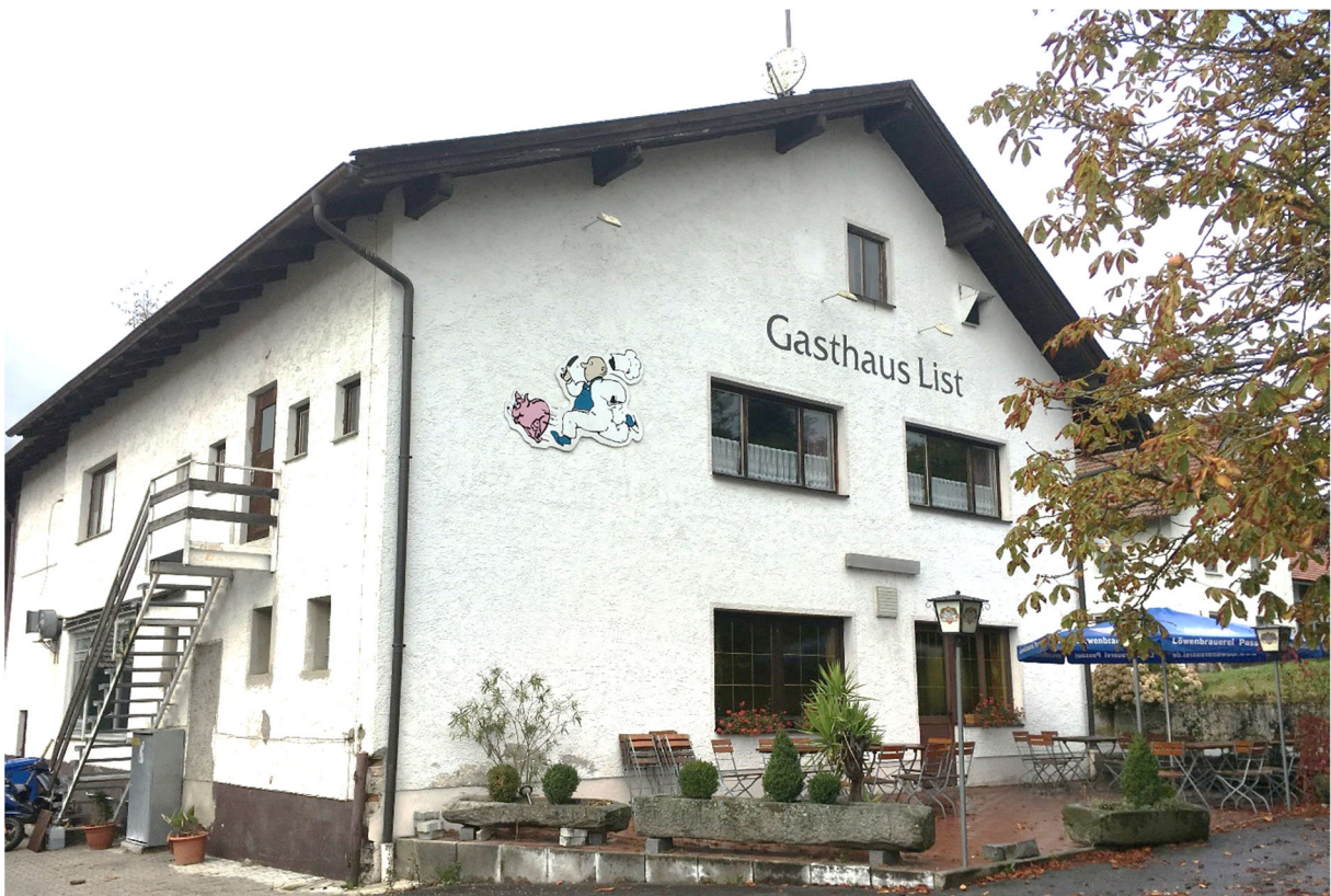
Abbildung 70: Blick auf das sanierungsbedürftige Hauptgebäude
