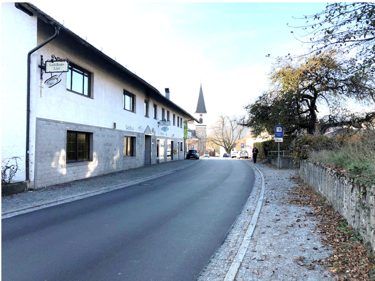
Abbildung 63: Diffuser Straßenraum Anwesen List, schlechte Parkplatzsituation
