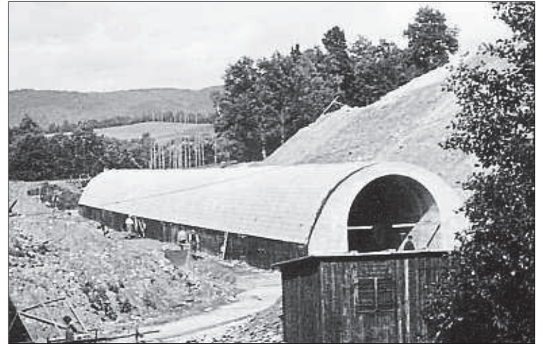
Bau der Mühlbogenunterführung: Das Buch widmet sich auch der Reichsautobahn und wird damit auch für die Leser über Schaufling hinaus interessant. – Foto: Archiv Florian Jung
